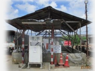
เทพื้นคอนกรีตยกขอบ บริเวณที่เก็บน้ำมัน
