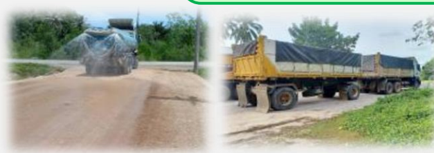
ฉีดพรมน้ำบริเวณพื้นที่ก่อสร้าง
