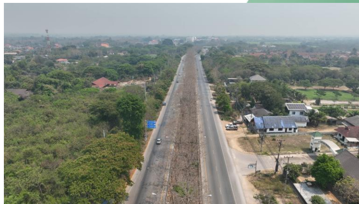
รูปการสำรวจสภาพพื้นที่แนวสายทาง ทล.1 ช่วง กม.1+250 โดย Drone
