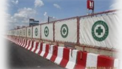
แผงกั้น (Concrete Barrier) แสดงขอบเขตพื้นที่ก่อสร้าง
