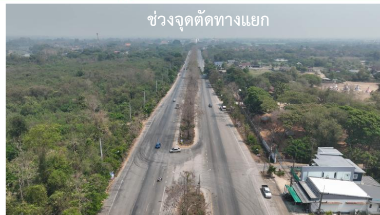
รูปการสำรวจสภาพพื้นที่แนวสายทาง ทล.1 ช่วง กม.1+000 โดย Drone
