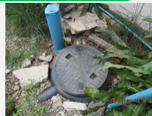
ติดตั้งระบบบำบัดน้ำเสีย
