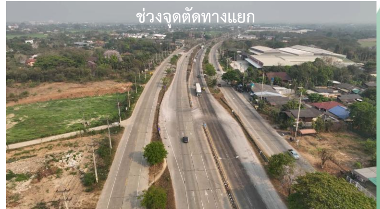
รูปการสำรวจสภาพพื้นที่แนวสายทาง ทล.11 ช่วง กม.1+000 โดย Drone
