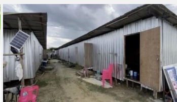
จัดให้มีบ้านพักคนงานก่อสร้าง
