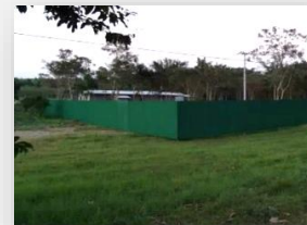
รั้วล้อมรอบ บ้านพักคนงานก่อสร้าง
